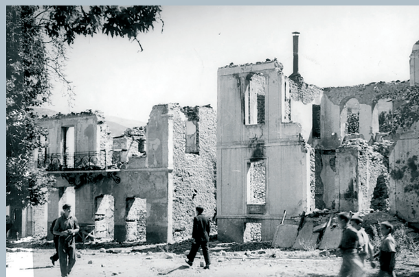
Τα Καλάβρυτα την επόμενη ημέρα μετά την καταστροφή. © Μουσείο Καλαβρυτινού Ολοκαυτώματος
